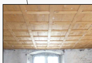
12_Wohnen Deckentäfer ist vorhanden und soll neu montiert werden.
