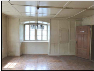
08 Wohnen Wand und Deckentäfer ist vorhanden und soll neu montiert werden.
