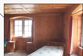
12_Wohnen Wand- und Deckentäfer ist vorhanden und soll neu montiert werden.
