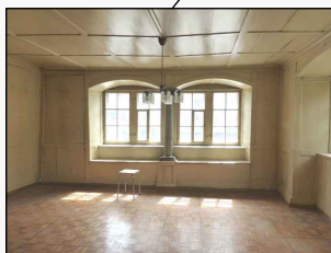
08 Wohnen Wand und Deckentäfer ist vorhanden und soll neu montiert werden.
