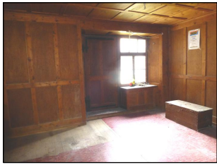
09 Zimmer Wand und Deckentäfer ist vorhanden und soll neu montiert werden.
