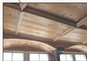
02_Wohnen Wand und Deckentäfer ist vorhanden und soll neu montiert werden.
